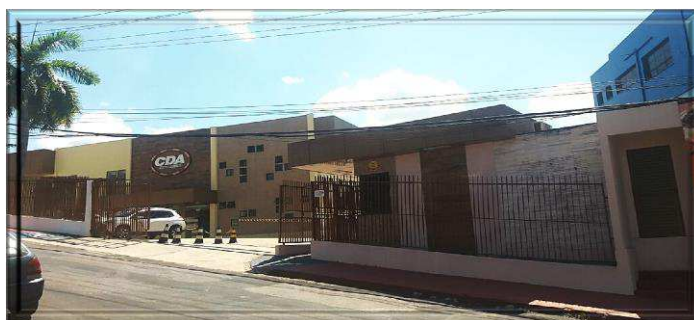
Construção de edifício comercial tipo galpão – área construída: 1.927,73m 2
